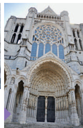
Façade ouest, à droite la tour sud, à gauche la tour nord.
